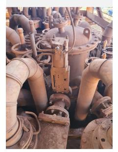
Una planta de concentrado de mineral de hierro en Brasil confía en nuestras válvulas de guillotina WG para para servicio severo en los hidrociclones.
